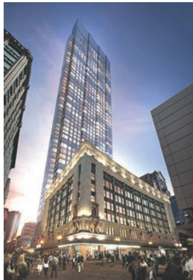
Millennium Tower ergue-se numa zona de excelência da cidade de Boston, nos seus 60 andares de altura e num projeto avaliado em 700 milhões de dólares.
